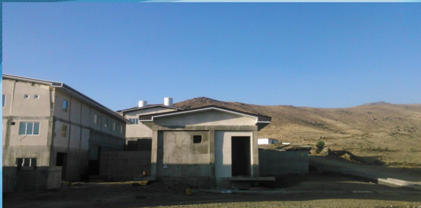
ساختمانهای تصفیه خانه
