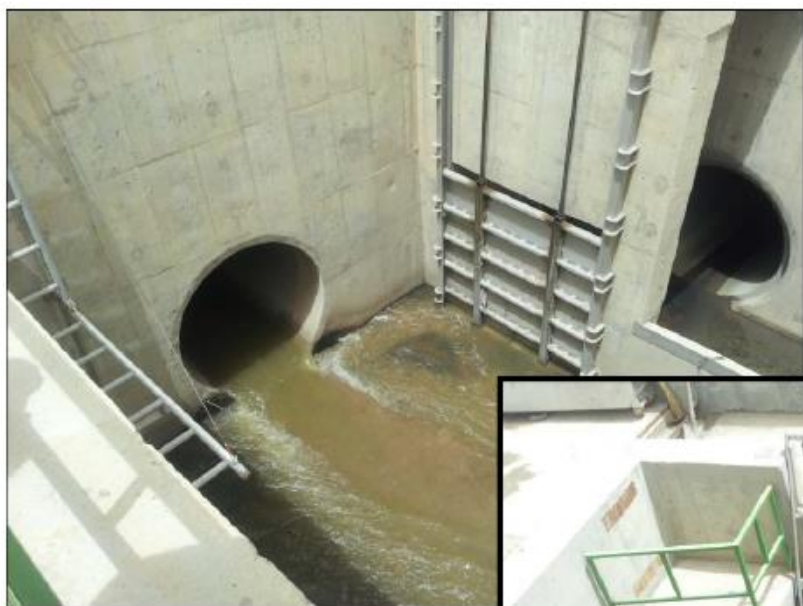
نمای سازه ورودی فاضلاب به تصفیه خانه
