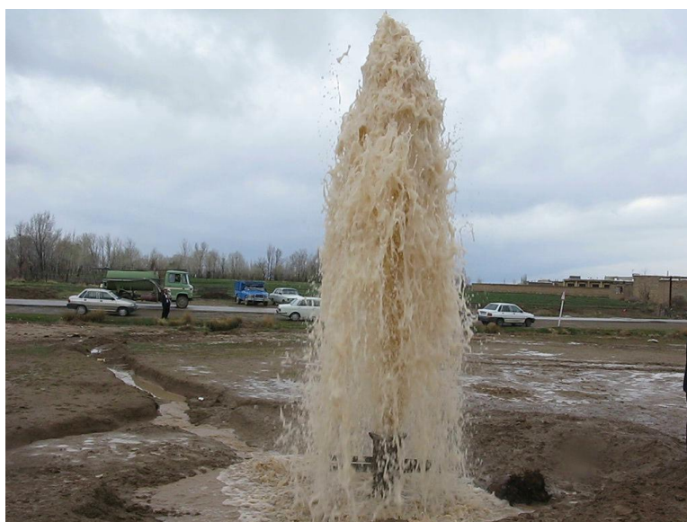
شکل شماره ۴: نمایی از فوران آب چاه شرب عمان
